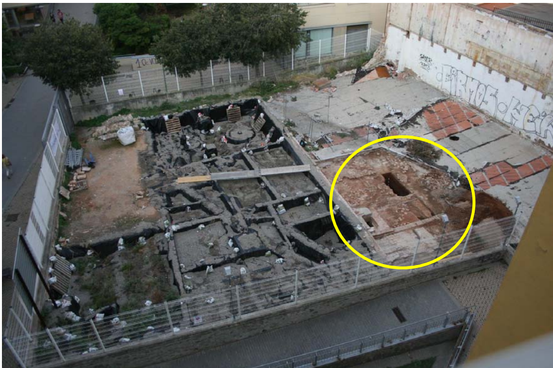
Vista general del solar des de l'ENE.
